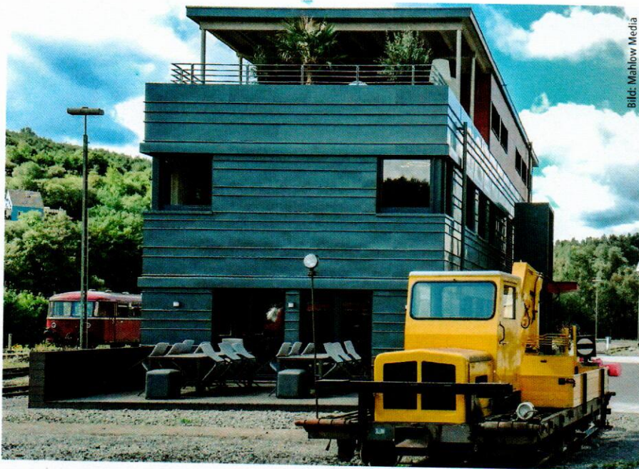
Die Kubatur und die Fassadengestaltung mit anthrazitfarbenen Titan-Zinkblechen mit einer horizontalen Winkelfalz erinnern an Bahnwagons und Schienenbusse.
