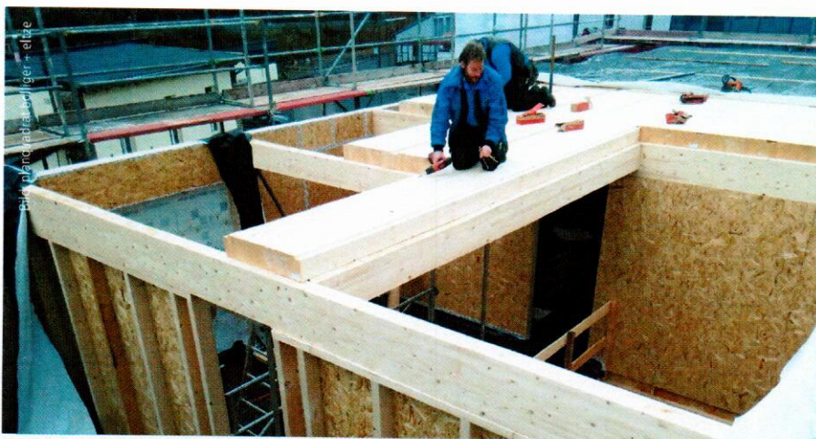
Die Innenwände bestehen aus Ständerwerk von 80 mm x 120 mm respektive 60 mm x 120 mm, die zunächst mineralisch gedämmt, dann jeweils beidseitig mit 15 mm OSB-Platten und am Ende mit 12,5 mm Gipskartonplatten bekleidet wurden.
