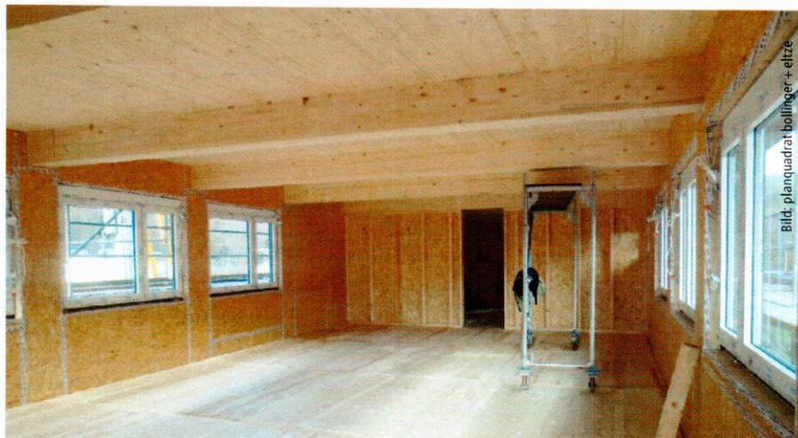
Auf der Brettstapeldecke des ersten OG folgten die Trittschalldämmung und die Trägerplatte für die Fußbodenheizung, die in den Zementestrich verlegt wurde. Als Bodenbeläge wählte man je nach Nutzung Teppichboden, Fliesen oder Linoleum.
